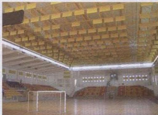
**Os painéis absorventes Mellowaffle, tipicamente usados para o tratamento de acústico de grandes espaços. Na imagem vemos o Pavilhão do Marítimo, na Madeira e o Pavilhão do Entroncamento algumas das instalações mais recentes da Jocavi**
