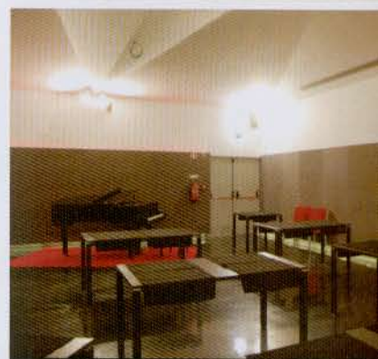
No portfolio da Audiodesigner, entre muitos projectos estão vários estúdios e bares. No bar, nas imagens, foi executado um tecto em gesso cartonado, perfurado em ângulos para não haver paralelismo com o pavimento. Também foram colocados painéis angulados em madeira (MDF pintado), à volta da sala para aumentar a absorção e a difusão acústica
